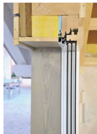
Schnitt durch ein Thermo-WIN Minergie Fenster.
