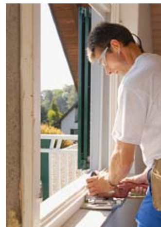
Live Fenstersanierung mit vielen nützlichen Informationen.
